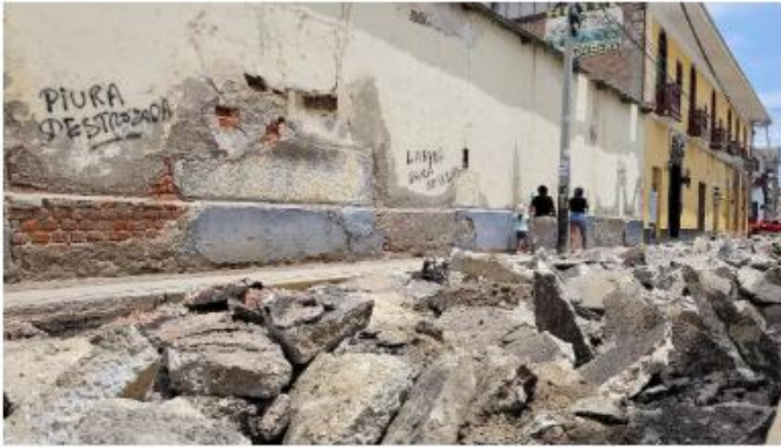
Obras estarían paralizadas.
